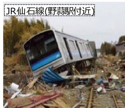
出典：東北地方整備局資料 ▲鉄道の被災状況
