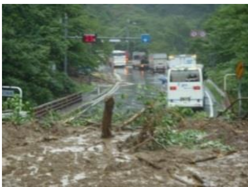
▲国道46号における崩土発生後の状況(H25.8.9)
