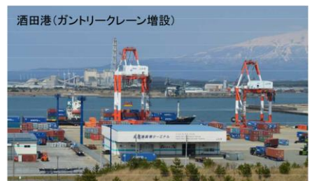
図4-21 国際コンテナターミナルの整備(例) 出典：東北港湾ビジョン
