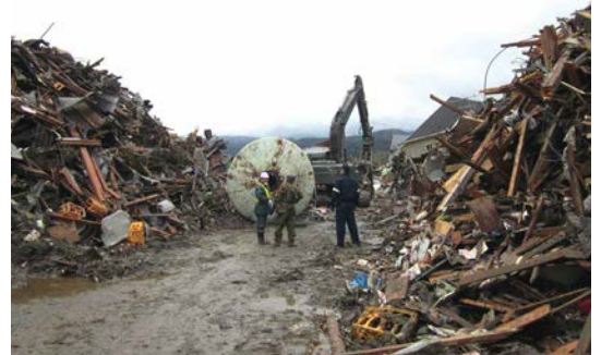
資料: 東日本大震災津波伝承館
