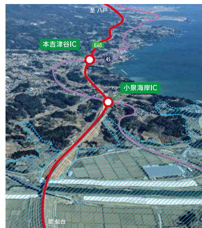
津波浸水域より高い位置を通過する三陸沿岸道路(写真1)
