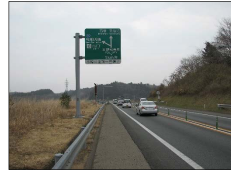
③松島北IC～鳴瀬奥松島IC間 (平成27年3月30日供用)
