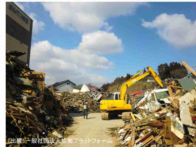
【写真④】：気仙沼市街地の啓開作業
