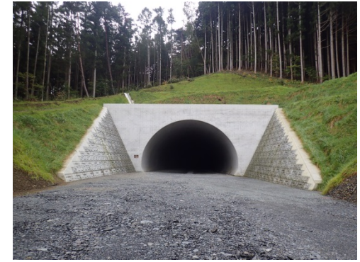
終点側坑口の現況
