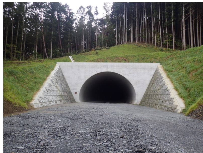
終点側坑口の現況
