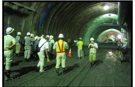
▲削孔状況の見学(トンネル坑内)
