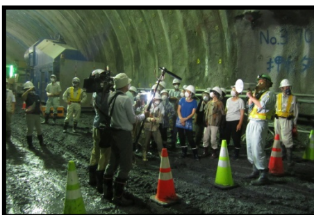
▲NATM 工法の説明(トンネル坑内)
