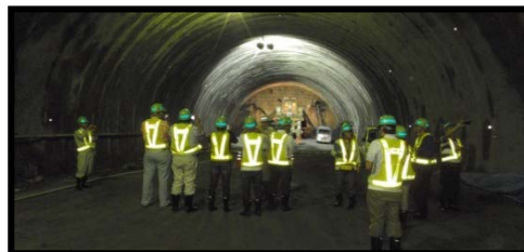
▲削孔状況の確認(トンネル坑内)
