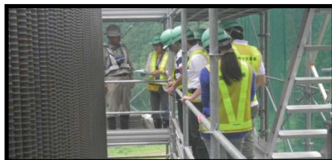
▲青野沢川橋の見学(P3 橋脚の足場内)
