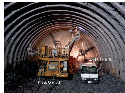
ロックボルト打設
