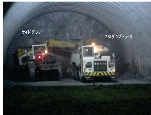
ずり出し状況
