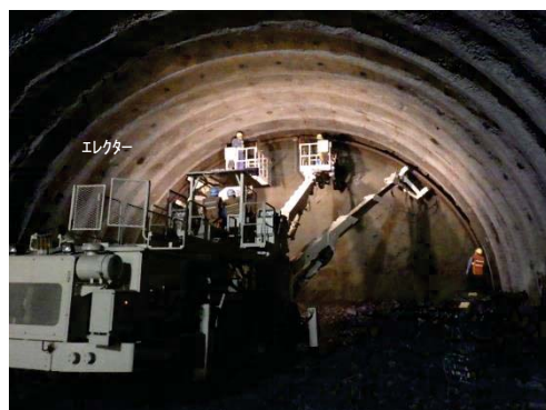
支保工建込状況
