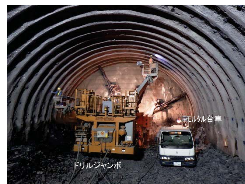
ロックボルト打設
