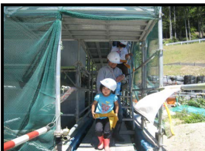
▲青野沢川橋の下部工を見学
