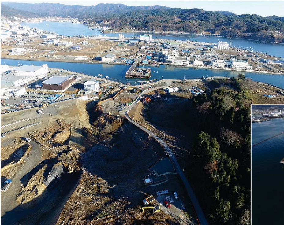
▲気仙沼湾横断橋A1橋台、P1～P4 橋脚部分の切土状況。工事は急ピッチで進められている。
