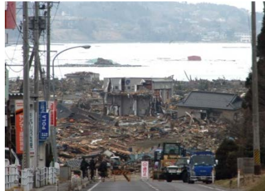
① 津波で瓦礫が山積み道路が寸断
