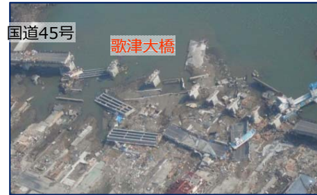
① 津波で落橋した国道45号歌津大橋
