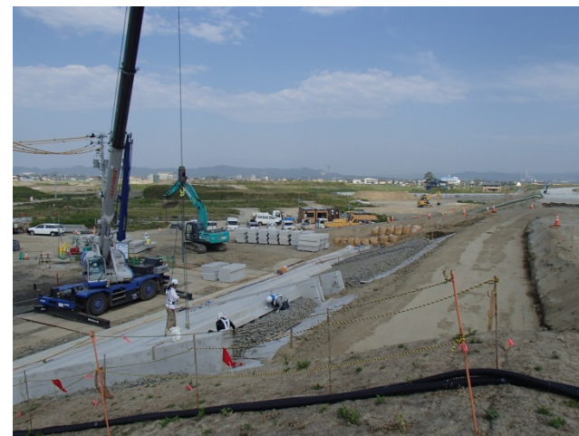
▲堤防復旧の工事状況
