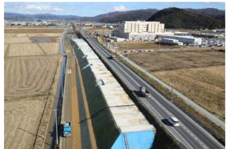
▲矢本石巻道路の4車線化工事状況
