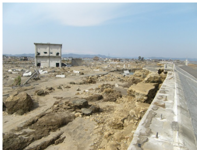
▲阿武隈川河口部の被災状況(H23.3時点)
