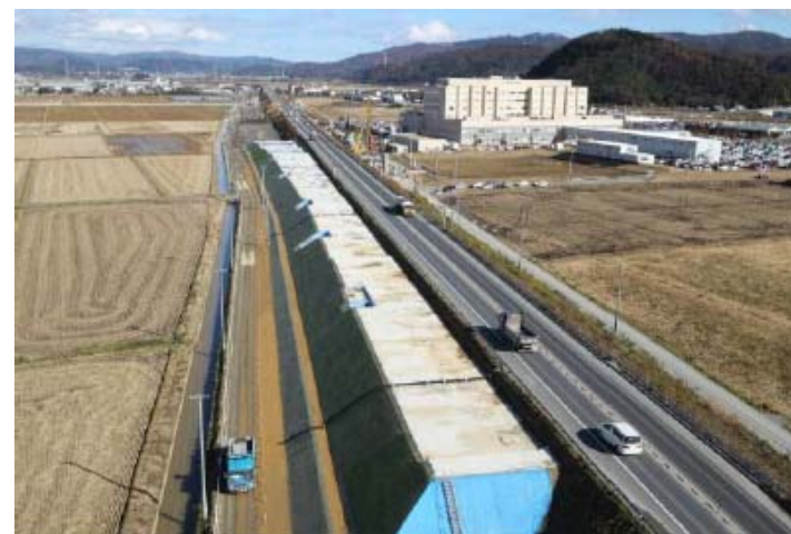
▲矢本石巻道路の4車線化工事状況
