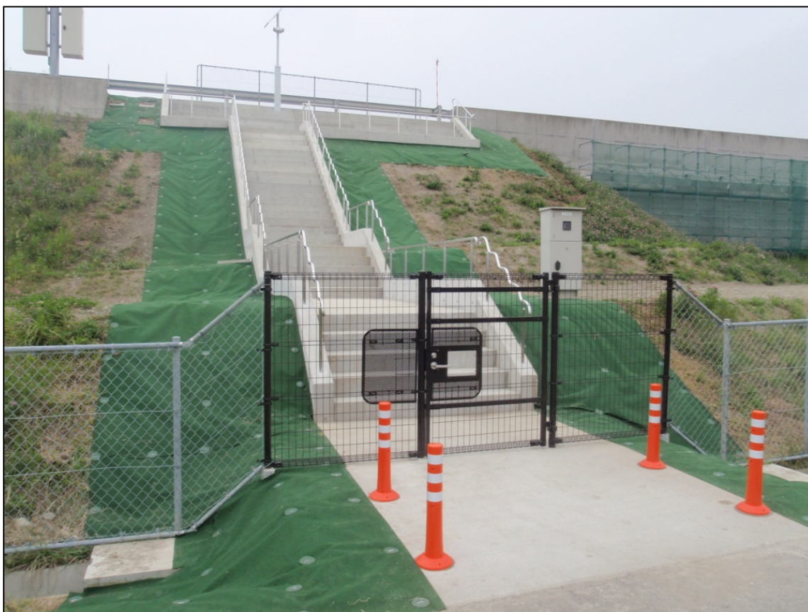
津波避難階段全景(伊勢前)
