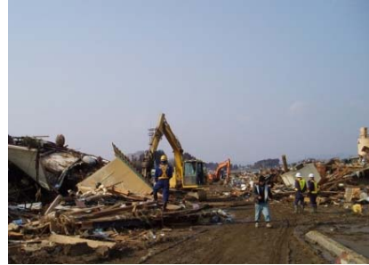
① 国道45号の被災状況
