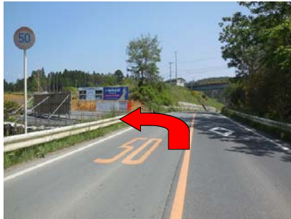
石巻方面から見た工事用道路出入口
