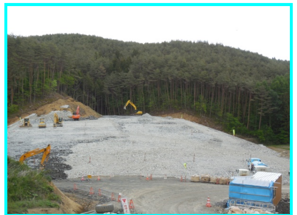
盛土現場の様子
