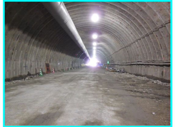
トンネル坑内の様子
