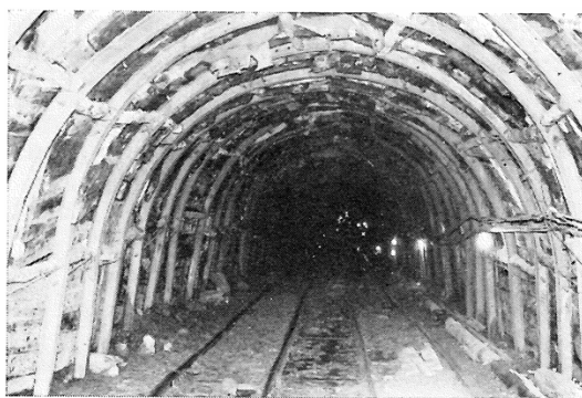
写-3-4-13 関(西口)坑口附近導坑支保工
