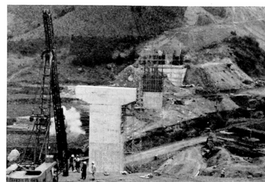
写3-2-8 加太道路(柘植川橋下部工)
