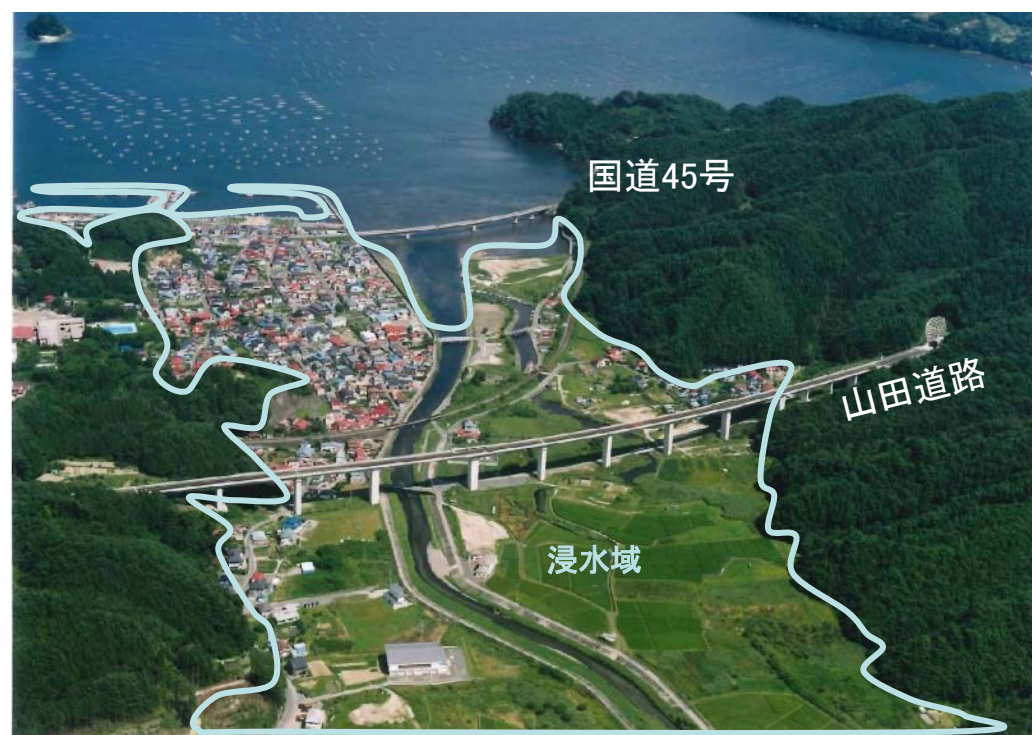
三陸縦貫道(山田道路)
