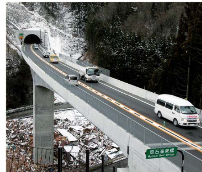
三陸沿岸道路「釜石山田道路」(H23.3.5開通)
