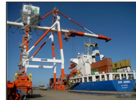
ガントリークレーン
