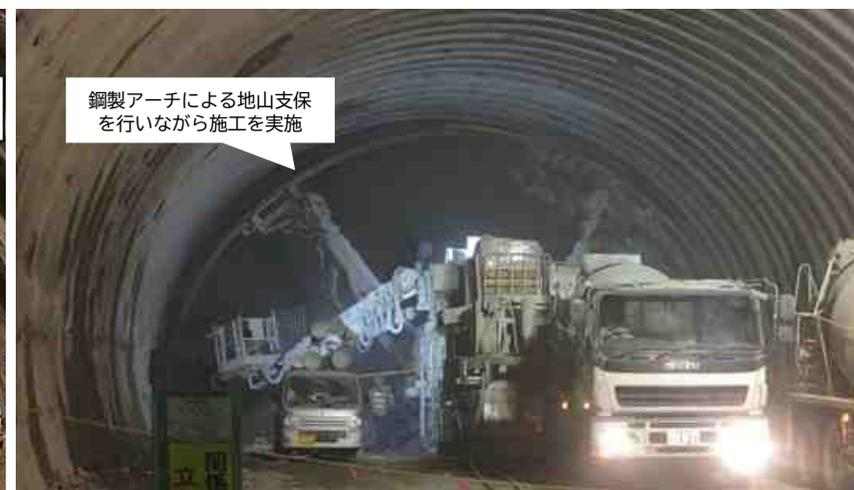
・掘削地山が脆く、崩れやすいため、鋼製アーチにより地山を支えながらトンネルを掘削
