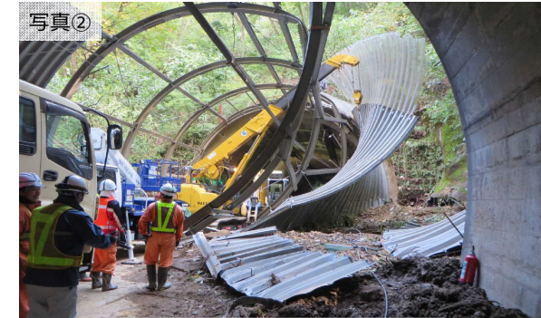
▼ 台風19号による被災状況 (宮古第3トンネル) (R1.10)
