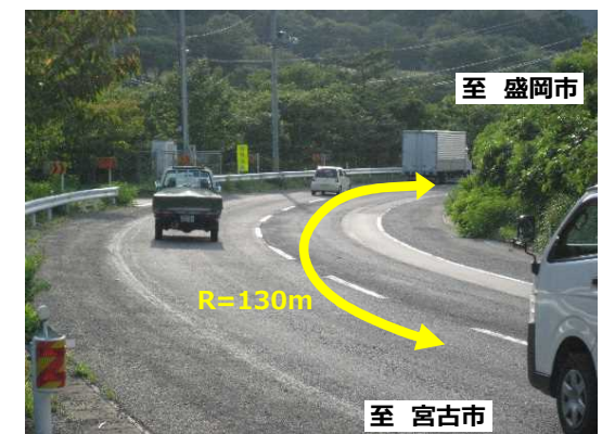
▼ 下川井地区並行現道の急カーブ (写真①)
