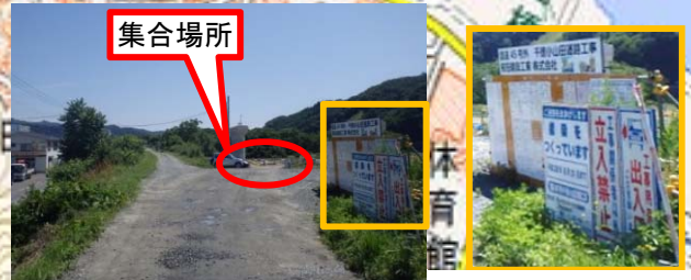
★分岐を右折し現場内へ 工事看板が目印
