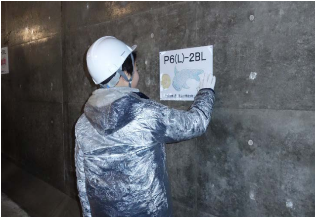
▲橋桁内部で、児童が描き入れた表示板の設置状況を見学
