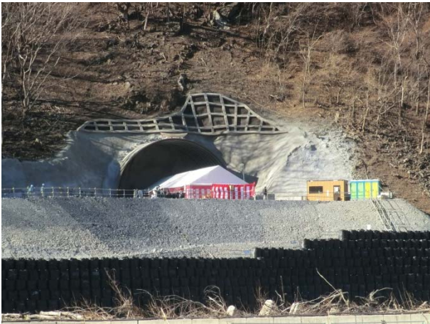
▲安全祈願祭会場全景(茂市トンネル)
