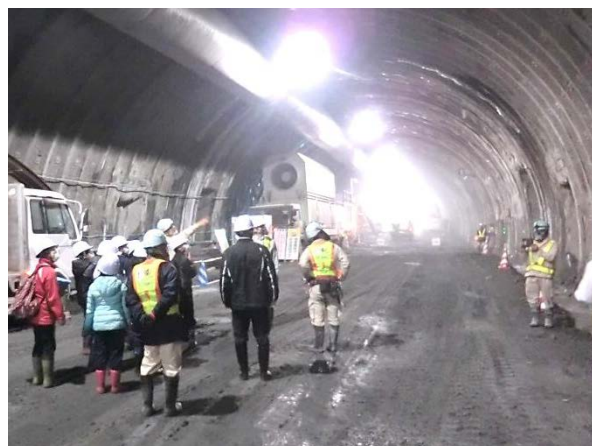
▲掘削中のトンネル構造の説明を受ける生徒の皆さん
