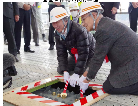
▲ボルト締結の様子
