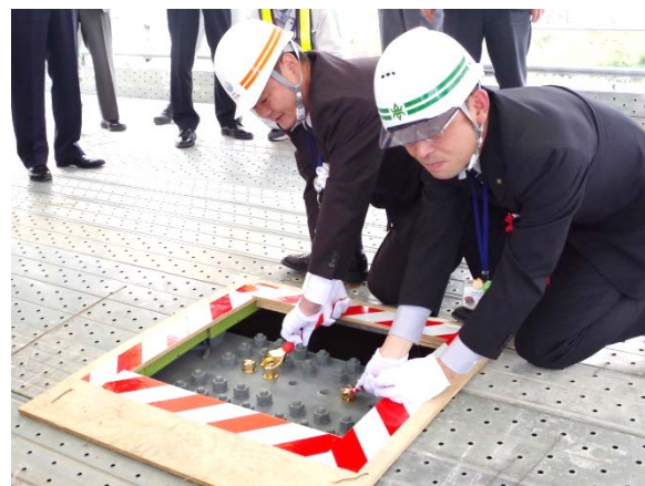
▲ボルト締結の様子
