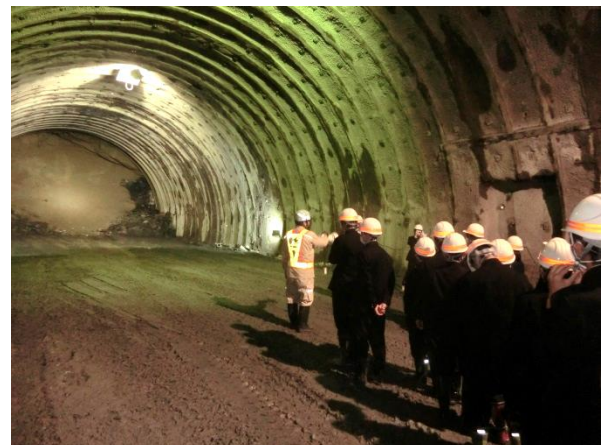
▲トンネル切羽を見学する生徒の皆さん
