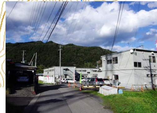
入口写真(盛岡側から)
