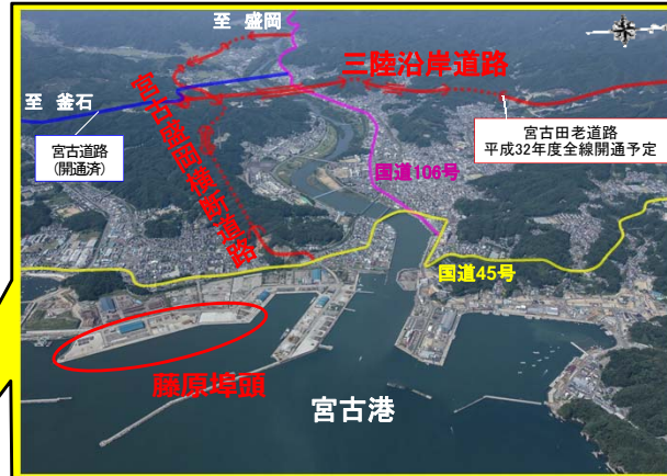
▼宮古港周辺の道路整備状況
