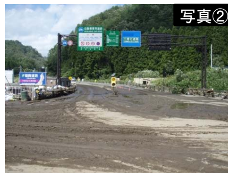
▼台風10号の被害状況 (岩泉龍泉洞IC入口)
