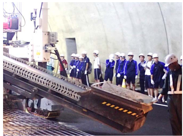
▲コンクリート舗装の施工見学
