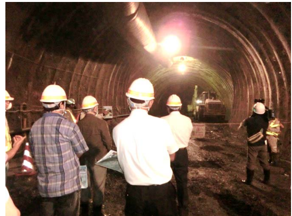
▲腹帯第1トンネルの施工状況を見学
