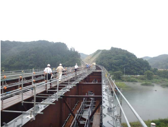
▲閉伊川橋上部工の施工状況を見学
