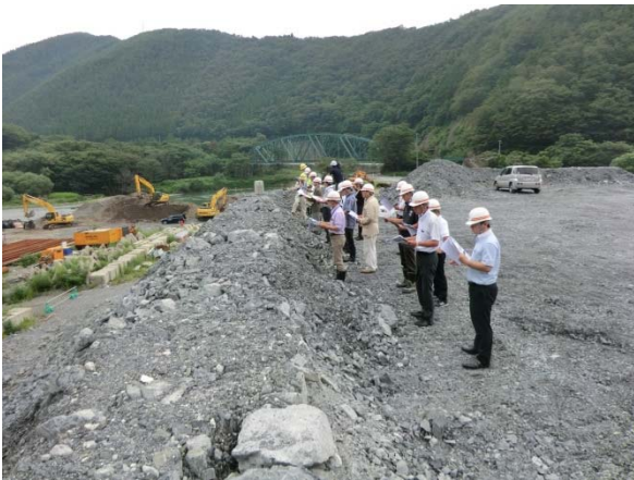
▲橋脚、工事用道路の施工状況を見学
