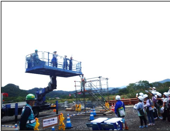
▲高所作業車上昇
