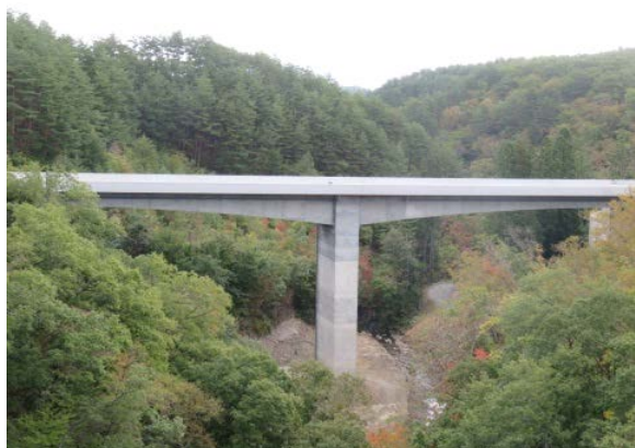
▲完成した青の滝川橋
