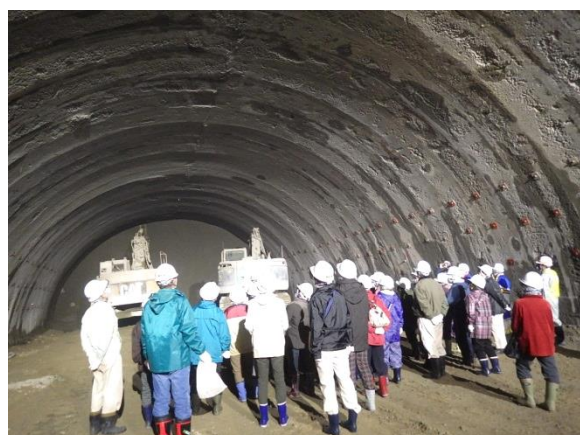
▲トンネル坑内見学の様子
