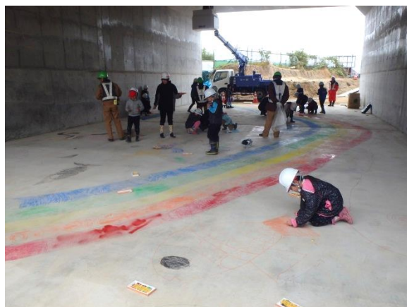
▲函渠工底版寄書きの様子
