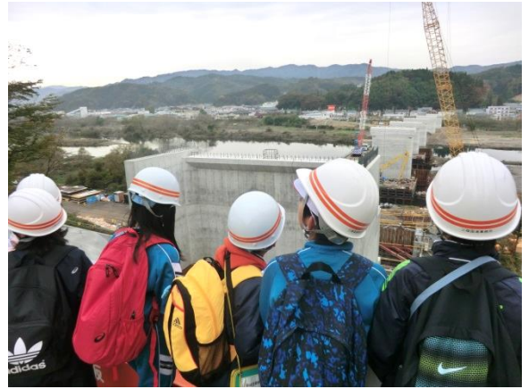
▲下部工の見学〔（仮）閉伊川橋〕
