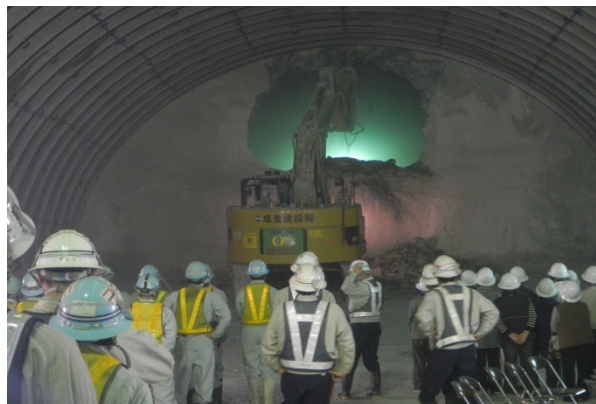
▲トンネル貫通見学の様子
