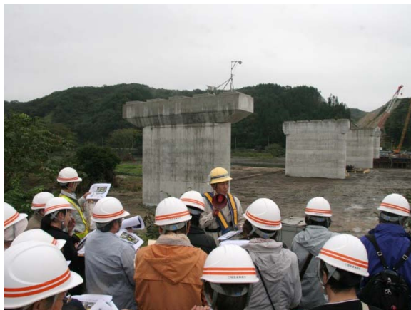
▲閉伊川橋下部工にて工事説明
