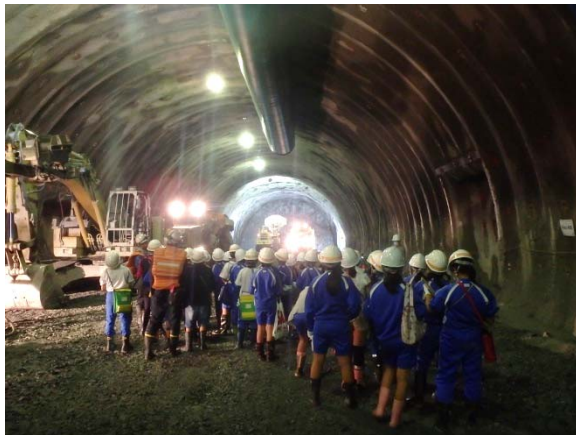
▲トンネル坑内見学の様子
