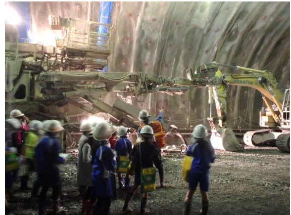
▲トンネル坑内見学の様子
