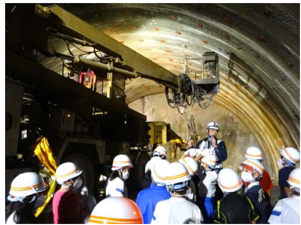
▲トンネル坑内見学の様子
