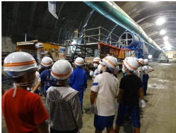
▲トンネル坑内見学の様子
