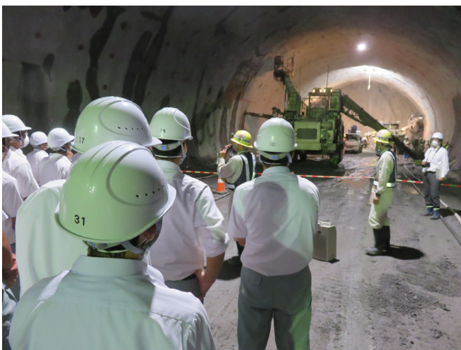
▲新鍬台トンネル 現場研修状況
