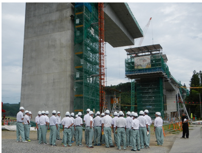
▲長部高架橋 現場研修状況
