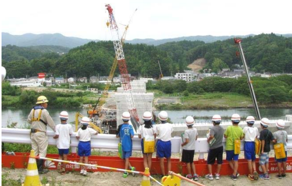
▲下部工の見学〔(仮)閉伊川橋〕
