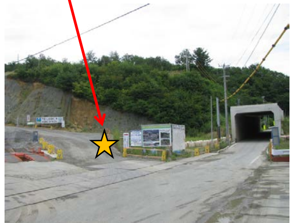
(仮称)小山田トンネル 現場(9:30頃) (仮称)閉伊川橋 下部工 現場
