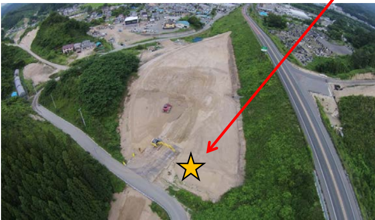
松山IC道路改良工事 現場(10:55頃) ・ICT土工
