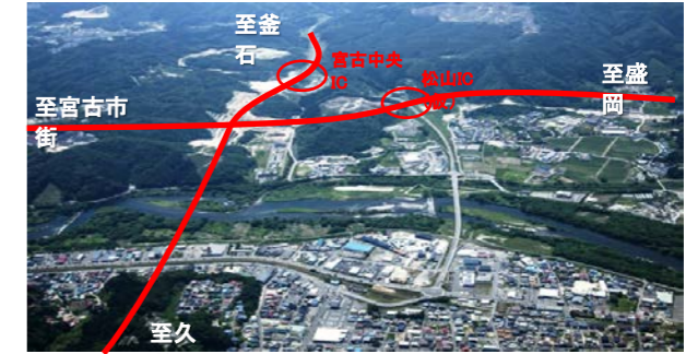
久慈方面から松山IC(仮)付近を望む
