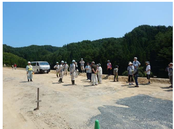
▲盛土区間現場見学
