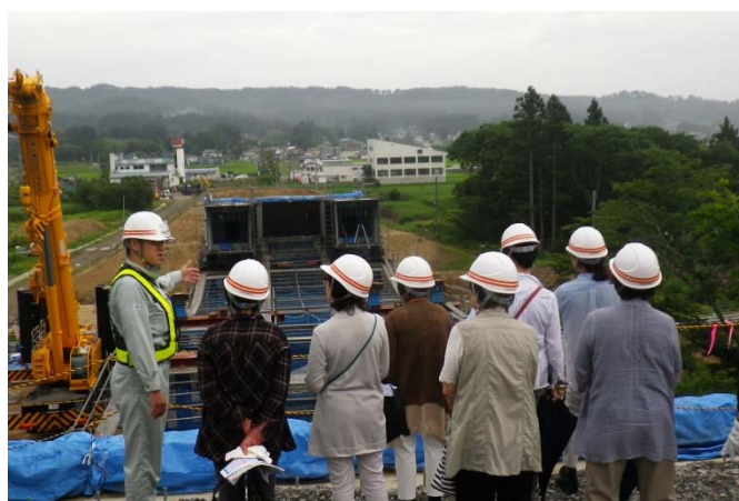
▲工事現場見学の様子
