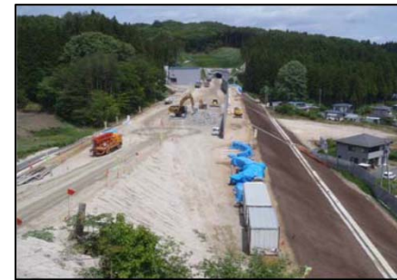
▲全景 (トンネル)
