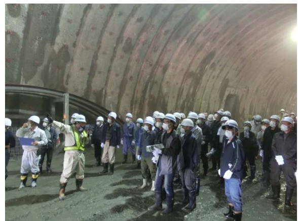
▲トンネル坑内にて工事概要説明
