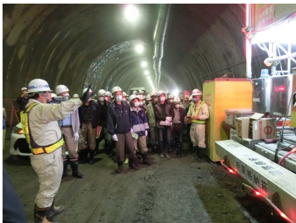
▲トンネル坑内安全施設説明
